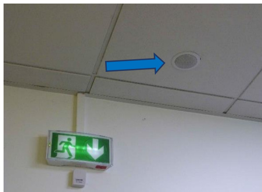
Figure 20 : balise sonore au plafond (flèche bleue), plus récente et plus discrète (bâtiment Cier)
