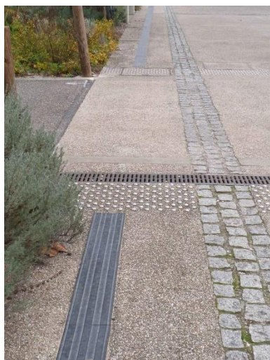
Figure 8 : BEV pour traverser une voie
