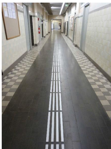
Figure 6 : bande de guidage métallique, bâtiment principal
