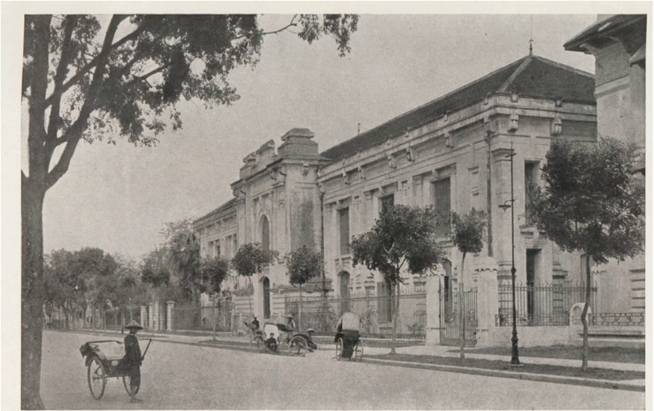
Figure 11 : École de Médecine et de Pharmacie de Hanoi – Vue d'ensemble de la façade.
