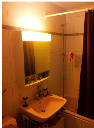
Figure 24: Eclairage après mise en place de la feuille de gélatine
