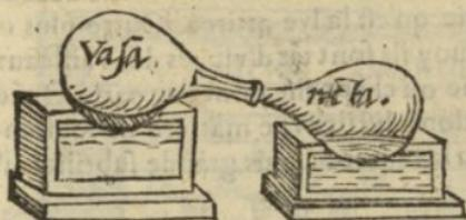
Or de peur q̄ les vaisseaux de vitre ne se rompent, ilz doiuent estre espes, & faictz de vitre blanc cuit lōg tēps en la fournaise, & qu'il ne ait aucunes pe-
