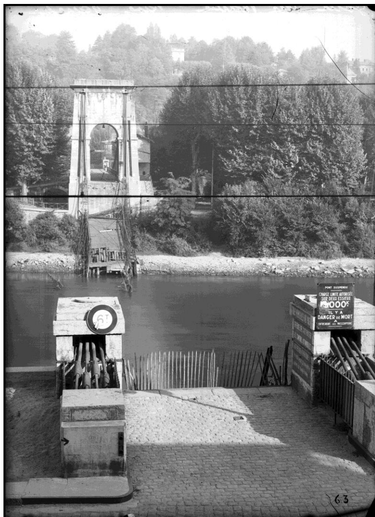
Figure 39 : Destruction du pont de l'Ile Barbe par les Allemands le 2 septembre 1944 (55)
