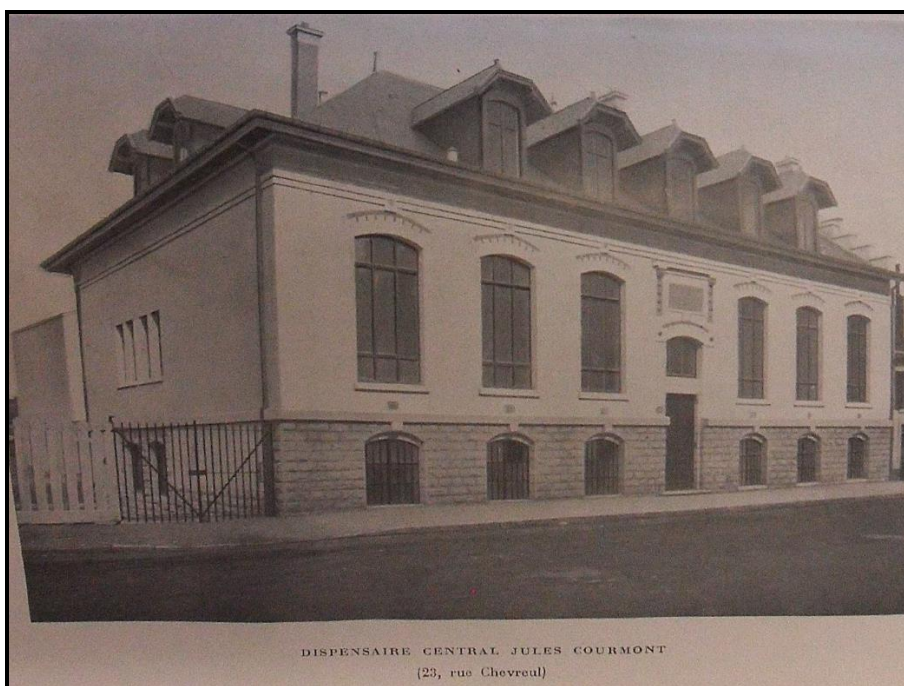
Figure 52 : Dispensaire central Jules Courmont, 23 rue Chevreul Lyon en 1933 (25)
