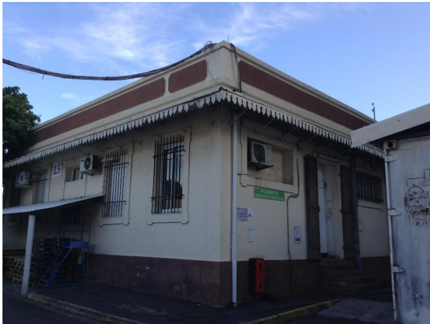
Figure 21 : Locaux du secteur des dispositifs médicaux au sein de la pharmacie de l'hôpital Gabriel martin
