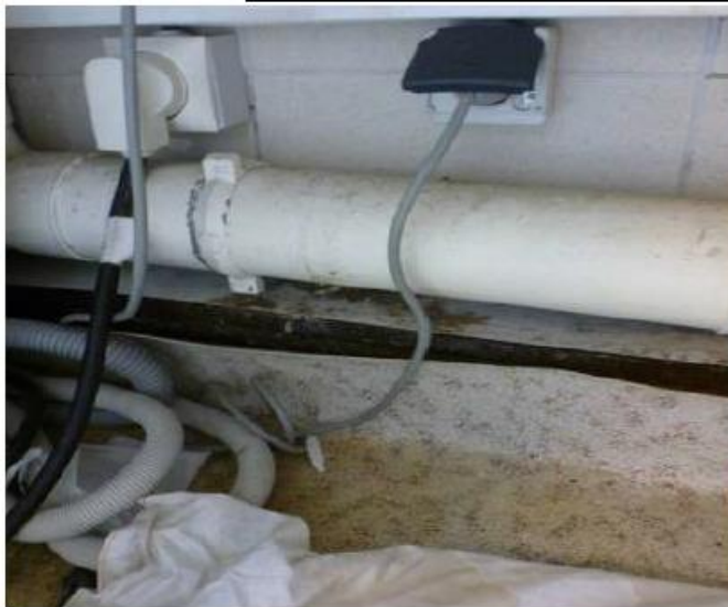
Derrière les laveurs-désinfecteurs (arrivées électriques, arrivée et évacuation d'eaux usées)
