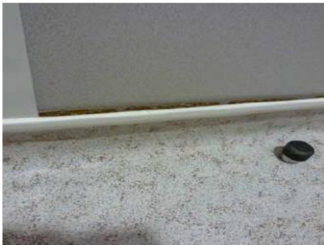
Décollement des plinthes : sol dans le sas (accès salle de conditionnement)
