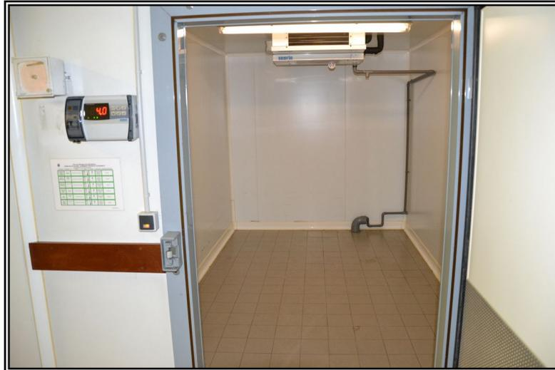
Photo 1 : Chambre frigorifique utilisée pour la réalisation de l'étude ; à gauche de la porte : réglage de la consigne de température et disque d'enregistrement de la température
